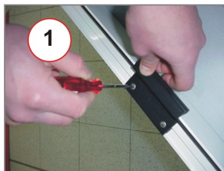
МОНТАЖ КРОНШТЕЙНА НА РАМУ
