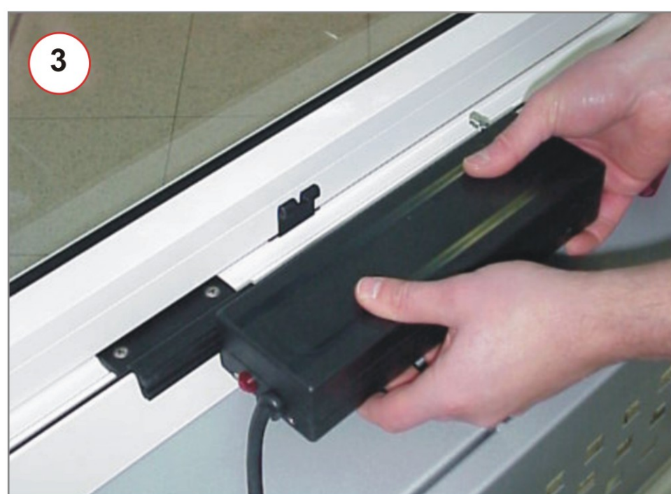
Монтаж привода на рамном кронштейне
